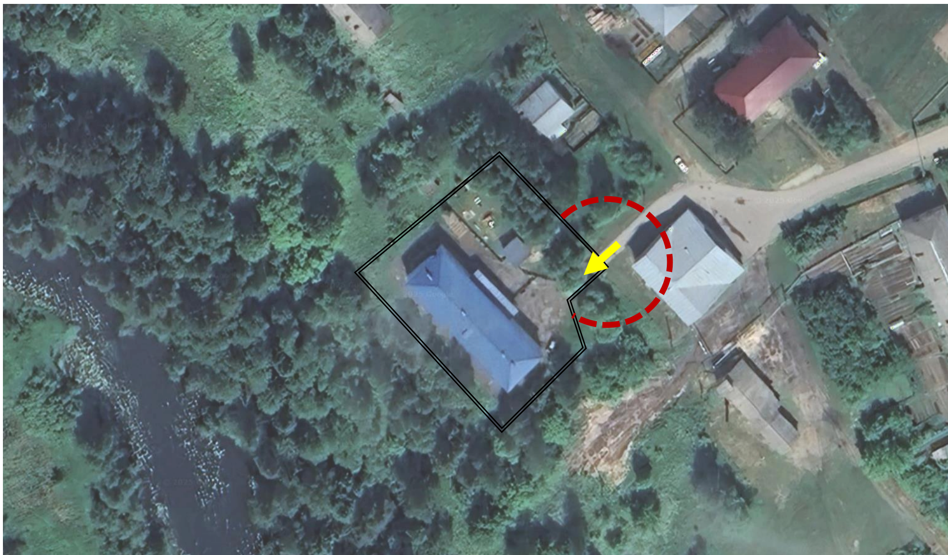
Большеустинский ФАП – с. Большое Устинское, ул. Набережная, д.3
